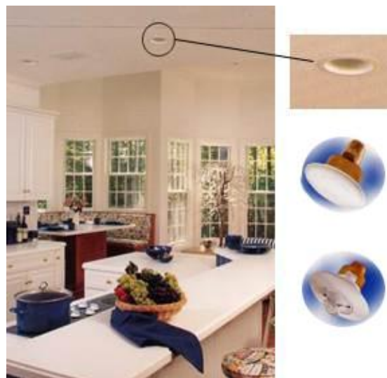
Van een woningsprinkler is niet meer te zien dan een wit plafondplaatje
