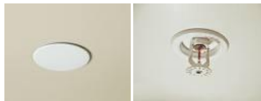
Woningenprinklers zijn onzichtbaar. Pas als door de brand de temperatuur stijgt valt er een plafondplaatje weg en komt de sprinkler tevoorschijn.
